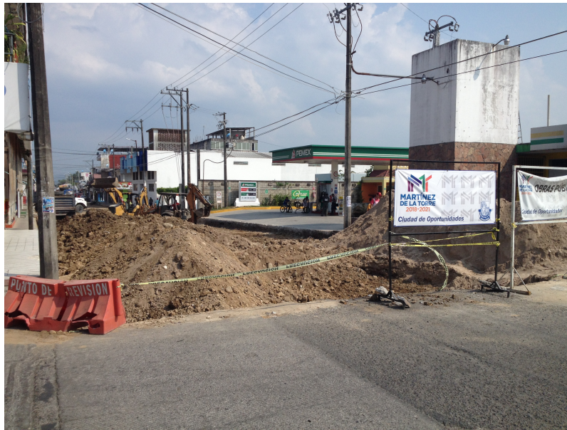
Figure 5.4: Tramo cortado por reparación
